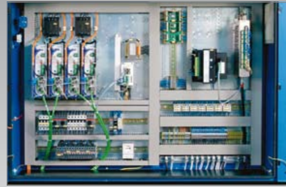
Armario eléctrico Amplio, accesible y correcta distribución de componentes. Incluye controladores digitales, transformador y CPU industrial.
